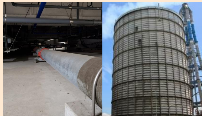
地下ピット/地下配管
